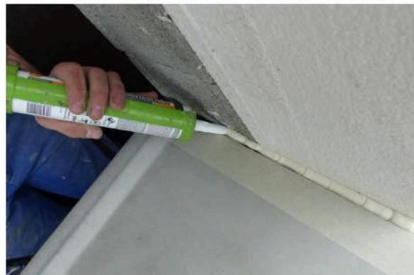
2. Procéder à un remplissage complet du vide laissé avec notre mastic colle souple et le pistolet afin d'assurer le **scellement latéraux des appuis**.
