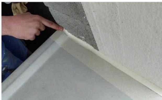
3. Enfin lisser le joint afin de permettre une mise en place parfaite du mastic pour assurer l'**étanchéité entre l'appui et le support**
