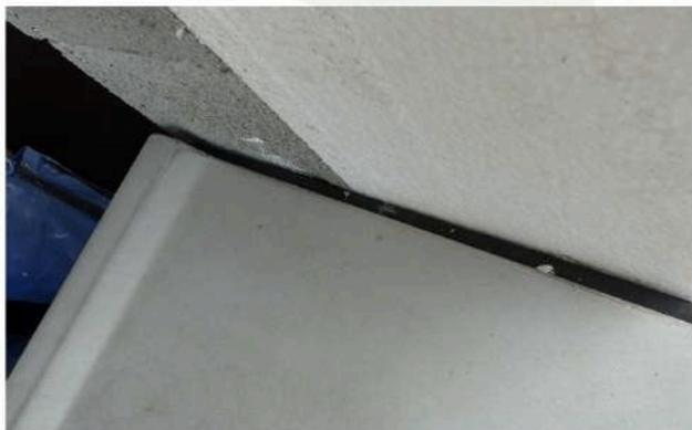
1. Insérer les fonds de joint de chaque côté de l'appui en les enfonçant légèrement (à 1cm du bord) dans les espaces laissés.
